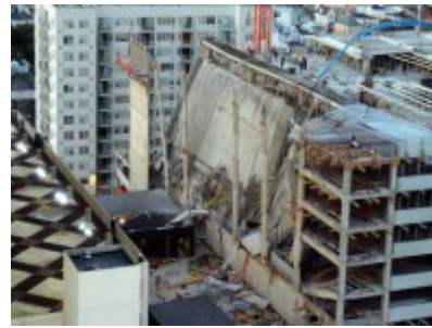
Rys. 1. Skutki katastrofy postępującej (opisy w tekście).
