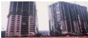
Rys. 1. Skutki katastrofy postępującej (opisy w tekście).
