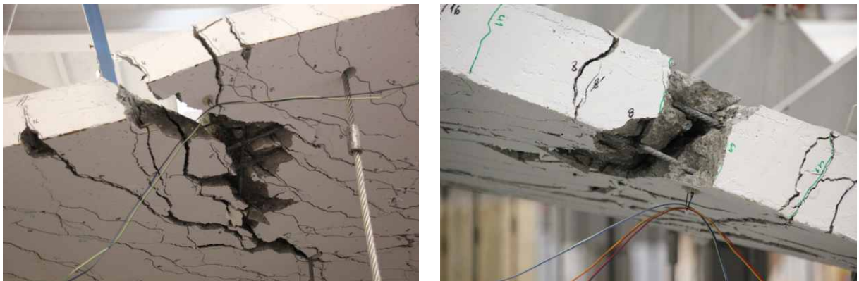
Rys. 84. Szczegóły zniszczeń Modelu 3
