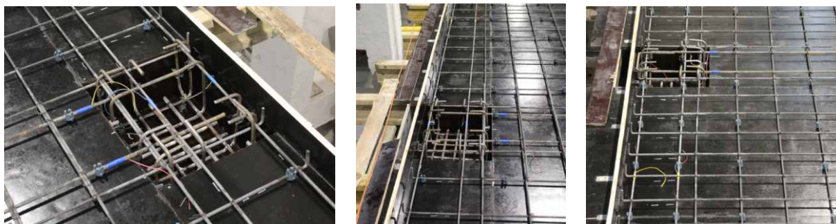
Rys. 65. Widok realizacji pomiarów odkształceń prętów zbrojeniowych:
