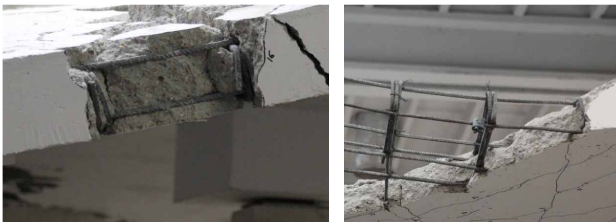
Rys. 41. Przykładowe widoki rozkutyh miejsc do przeprowadzenia pomiarów położenia zbrojenia
