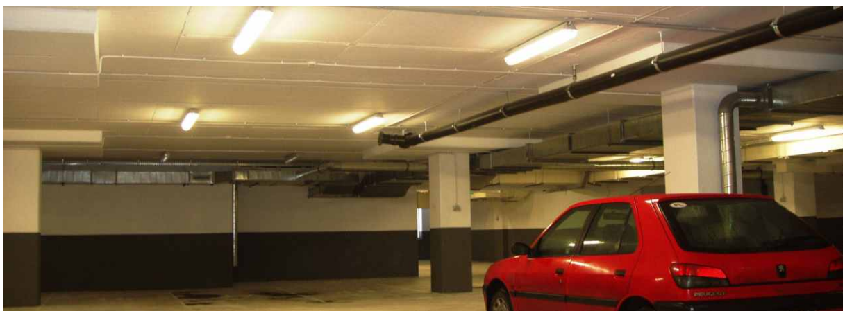
Rys. 2. Przykłady budynków o konstrukcji płytowo-słupowej (fot. Z. Pająk)
