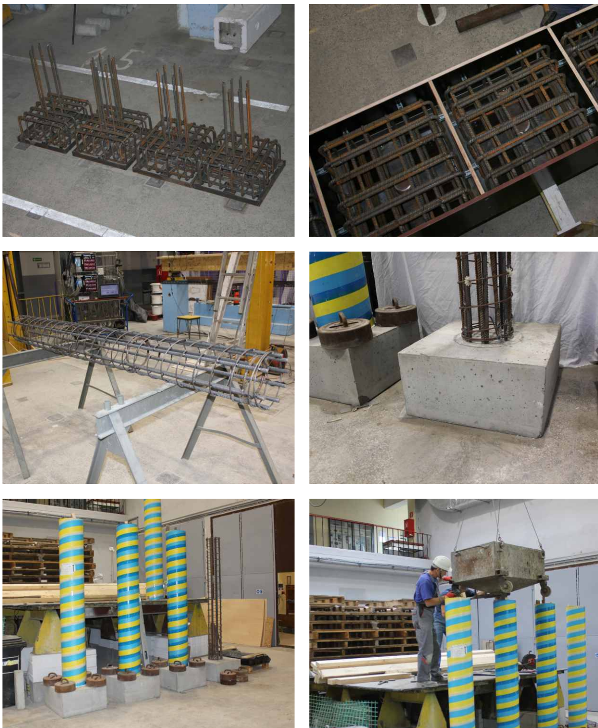
Rys. 22. Zdjęcia z procesu wykonania podpory słupowej
