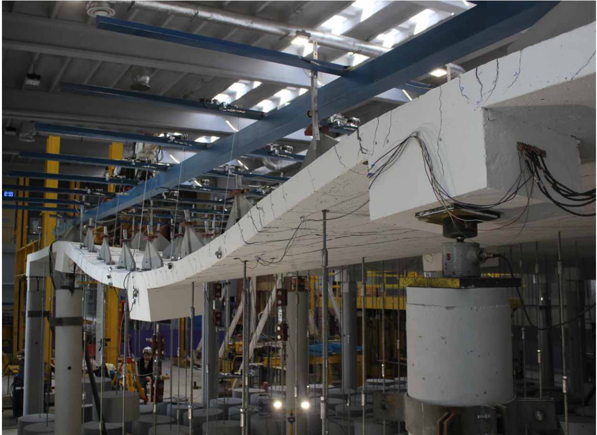
Rys. 77. Widok po zniszczeniu Modelu 1 – krawędź boczna
