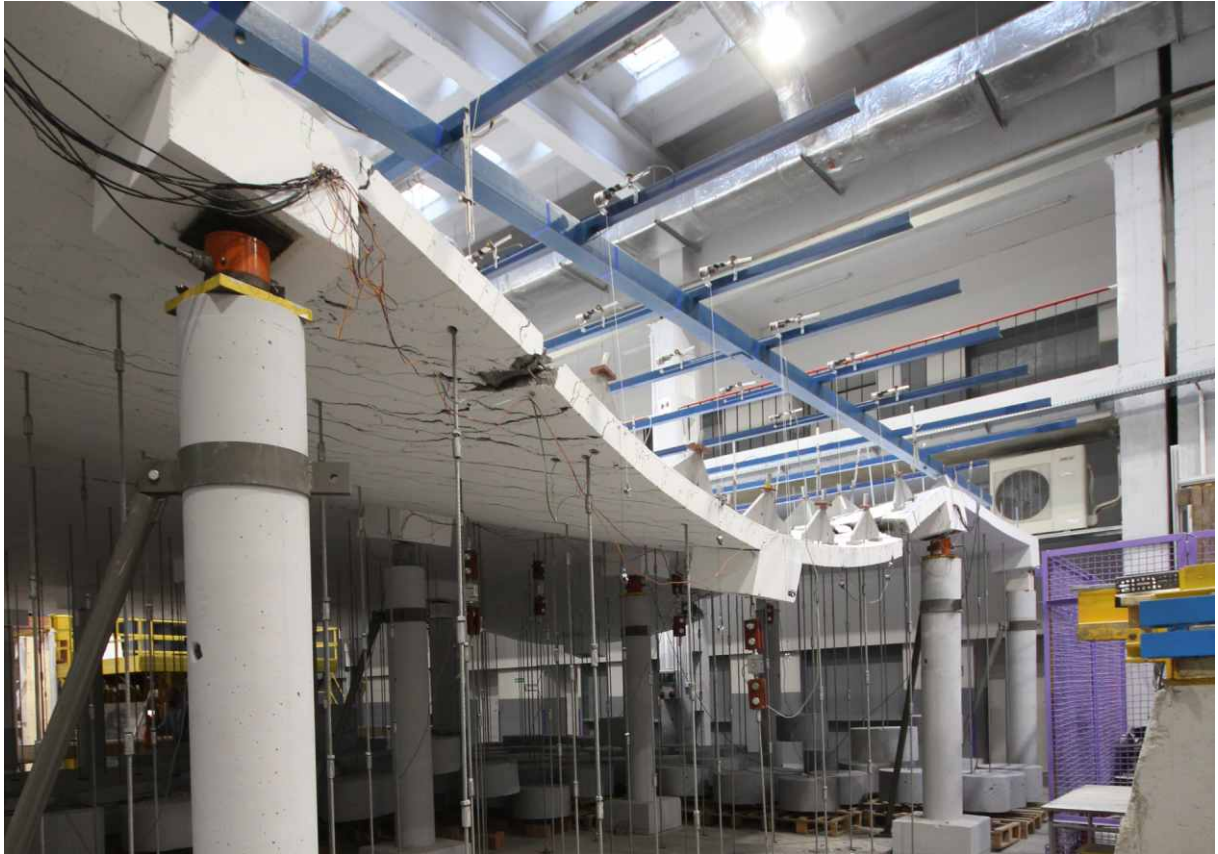
Rys. 83 Widok po zniszczeniu Modelu 3 – krawędź boczna
