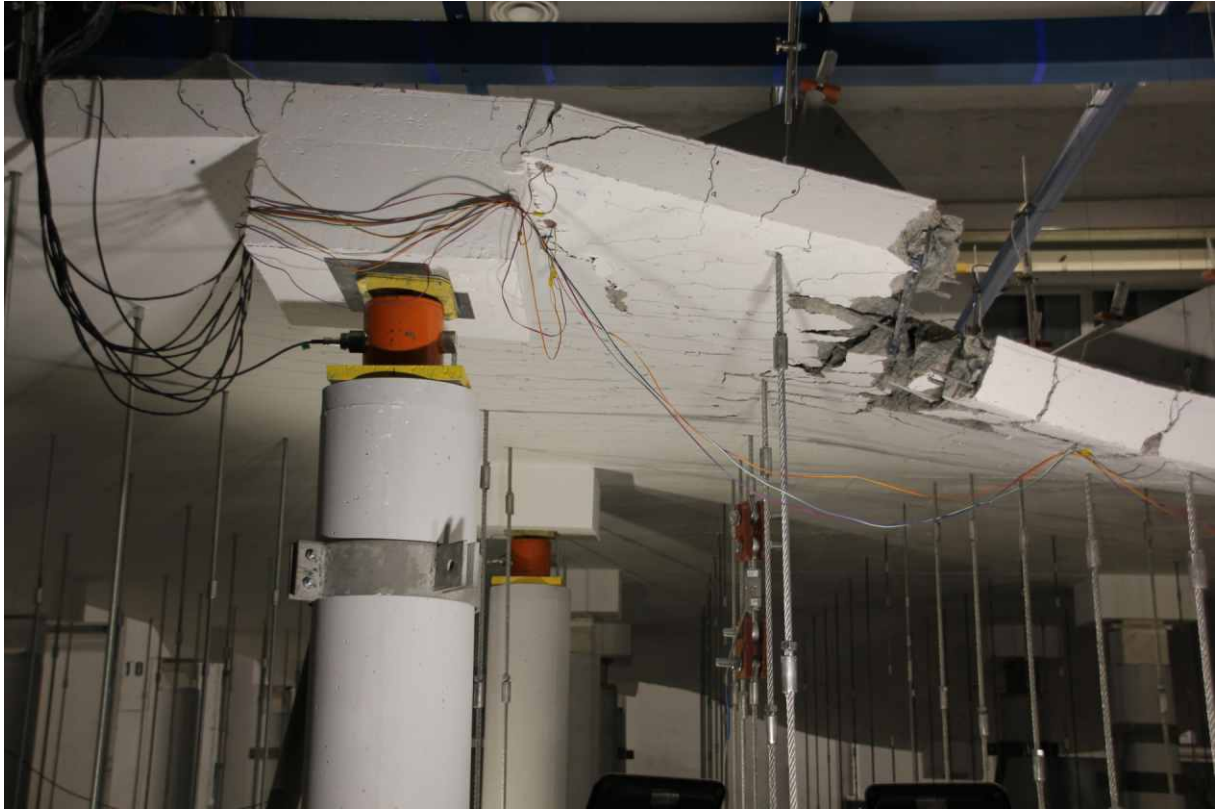
Rys. 80 Widok po zniszczeniu Modelu 2 – krawędź boczna
