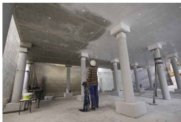
Rys. 39. Malowanie płyty
