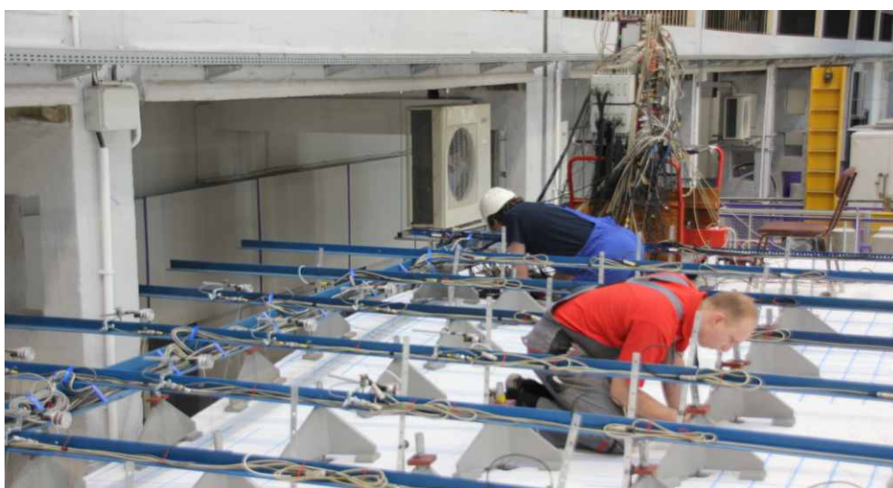
Rys. 53. Przebieg badań – odwzorowywanie zarysowań na górnej powierzchni płyty
