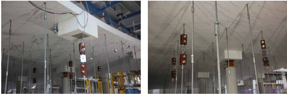
Rys. 61. Widok realizacji pomiarów obciążenia
