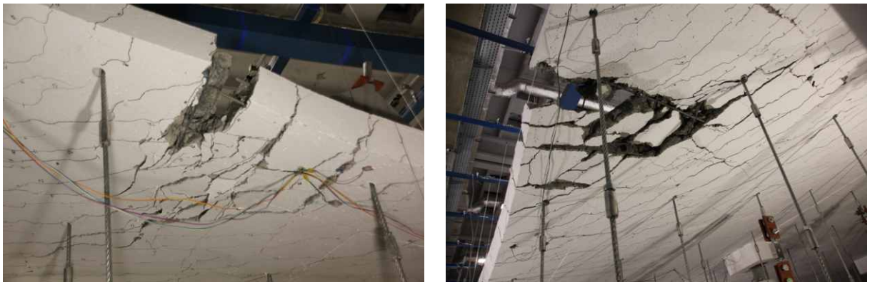
Rys. 81. Szczegóły zniszczeń Modelu 2
