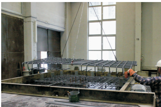
Rys. 15. Przygotowanie modeli badawczych: a) widok deskowania - dolna płyta deskowania z zamontowanymi burtami, słupki kształtujące otwory w płytach, deskowanie słupa, b) transport i widok ułożonego zbrojenia w formie.
