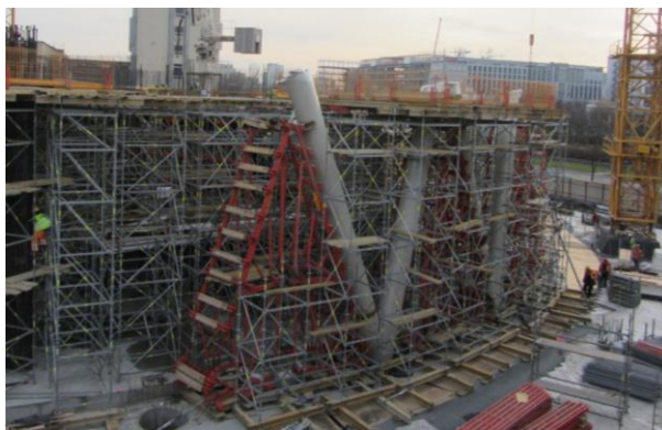
Rys. 2. Słupy V w budowie. Stan z grudnia 2013 roku.
