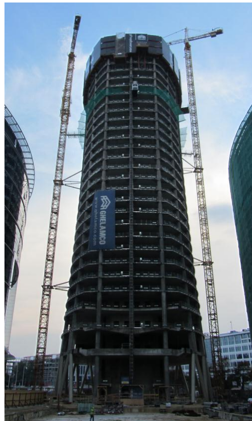
Rys. 6. Budynek wieżowy w budowie. Stan obecny.
