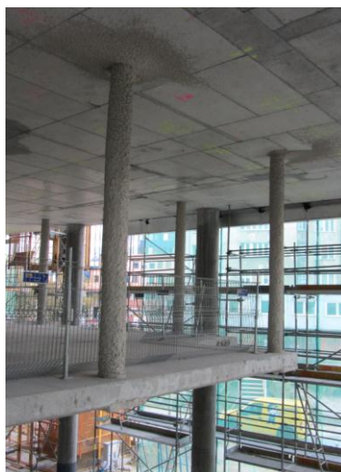
Rys.4. Fragment płyty stropowej wraz z mocującymi ją wieszakami.
