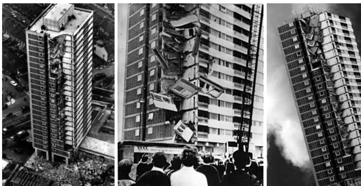
Rys. 1. Budynek mieszkalny Ronan Point w Londynie w Anglii [50].
